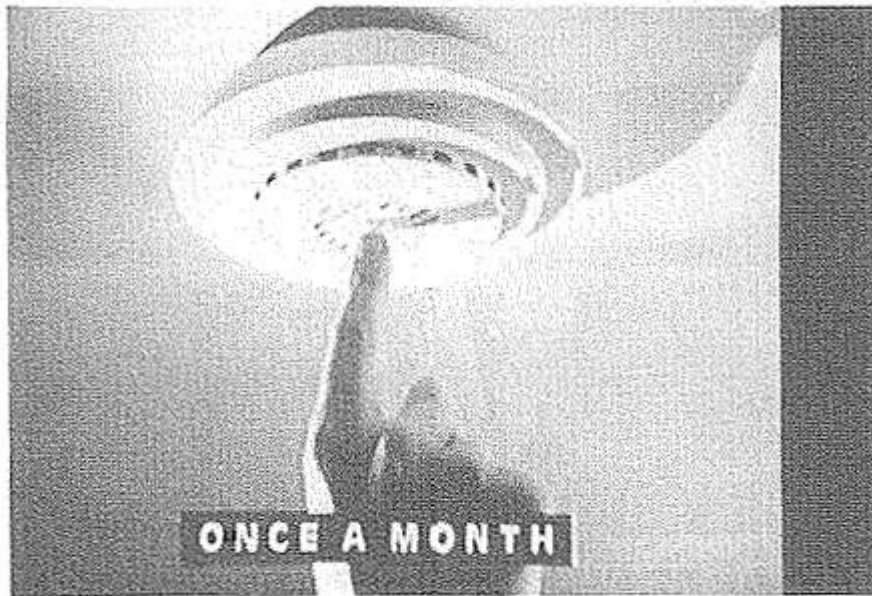
煙感知器の点検方法の映像（ITN から）
