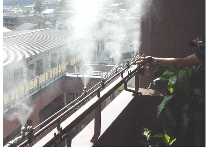
図 1: 一般家庭に設置された第1世代小規模噴霧型ドライミスト装置
