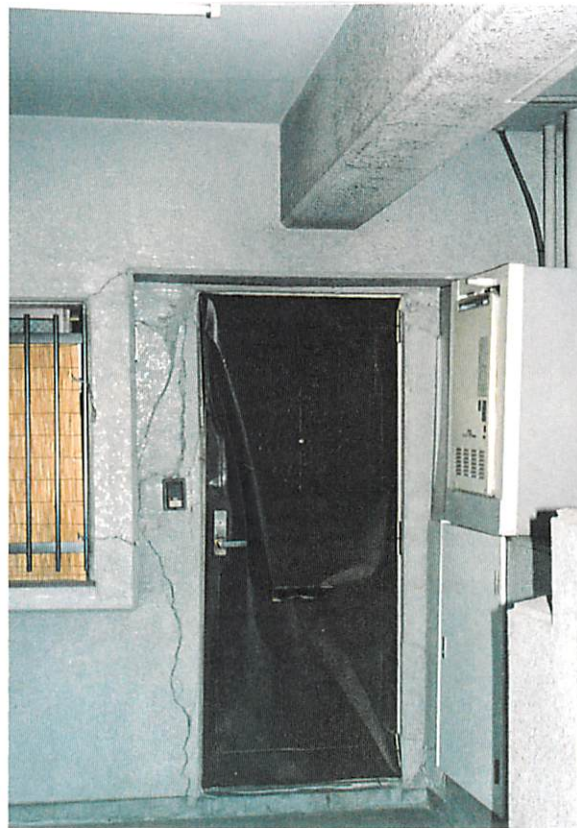
図4.3 変形したドアの例
