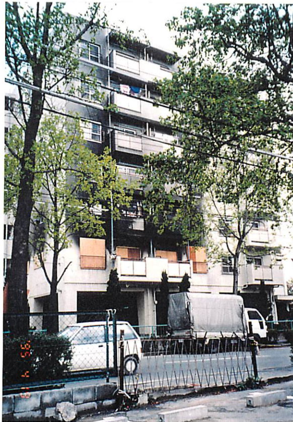
図4.11 調査対象建物
