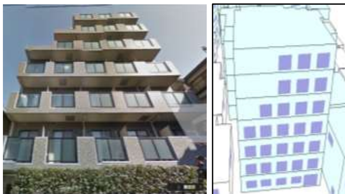
図 3.3-3 実際の建物とシミュレーションの建物の比較 1
