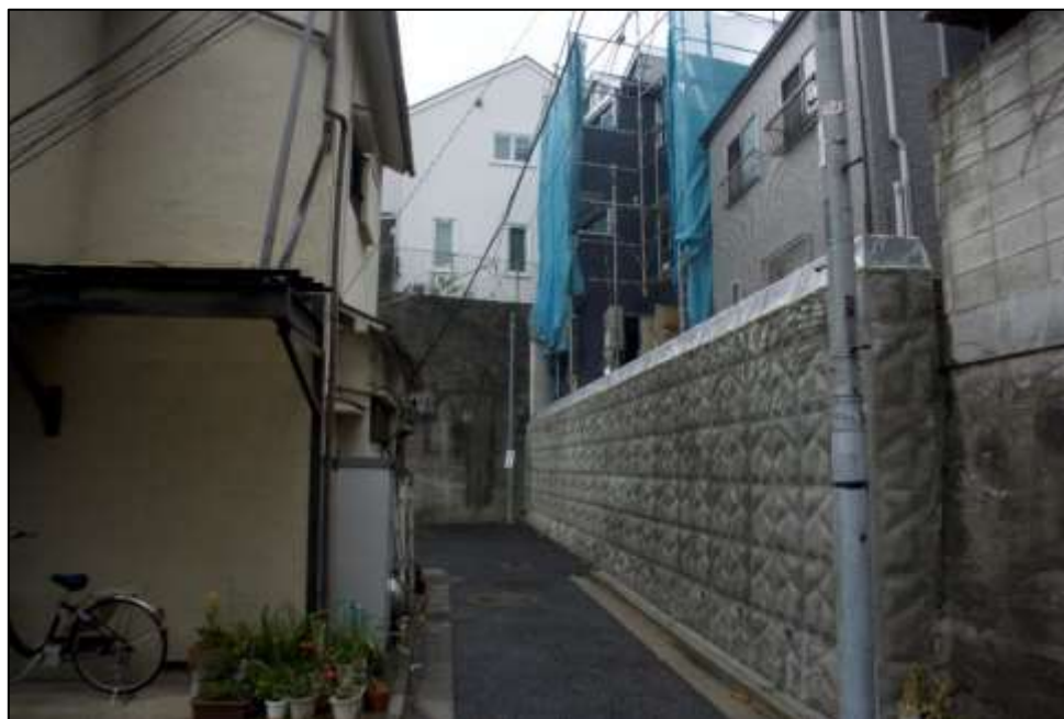
図 4.2-16 実際の建物 A と建物 B の写真
