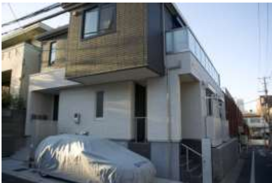
図 3.5-12 防火造（強め）の建物 1
