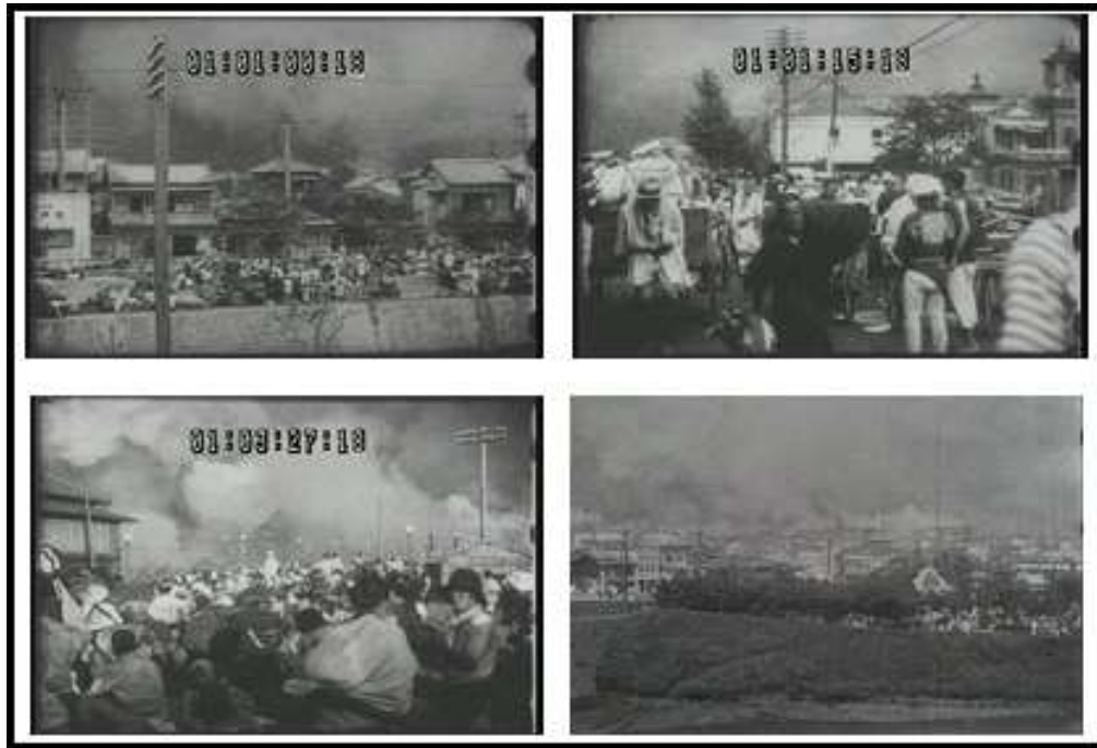
図 4-1 火災シーン（一部抜粋）
