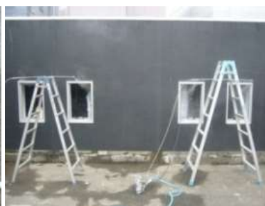
後方からのノズル設置状況
