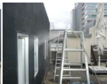
側面からのノズル設置状況
