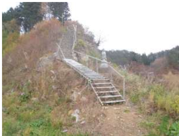
写真 - 4-3 傾斜避難路・野原側（平成 24 年 11 月 22 日）
