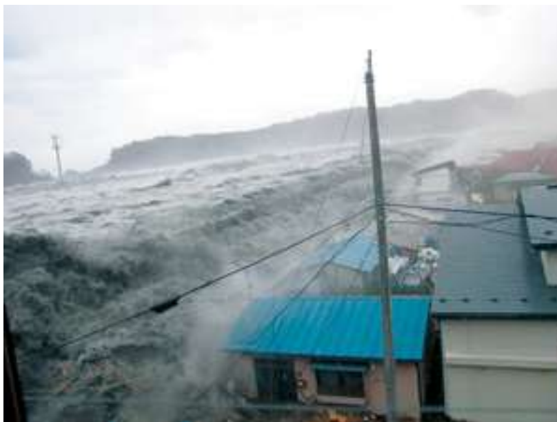
写真-2-2 津波が防潮堤を乗り越えた瞬間
