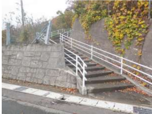
写真 - 4-4 傾斜避難路・旧田老側 (平成 24 年 11 月 24 年)
