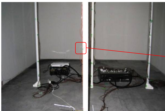
図 3.9 熱電対設置写真
