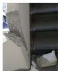
外部階段手摺(4階部分)
