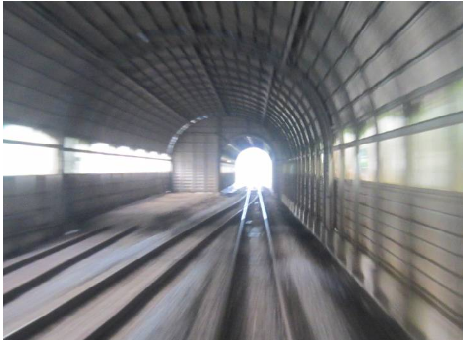
写真1: スノーシェルター {本件火災現場とは無関係 (撮影: 今和俊)}
