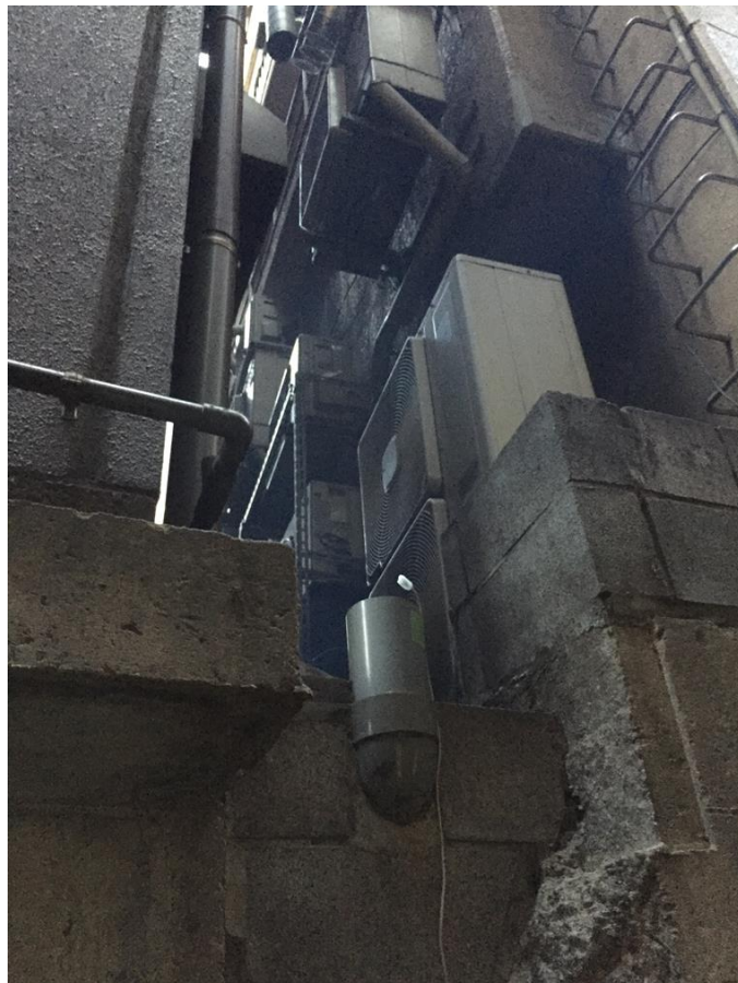
<図 8. ポルタ裏ダクト上部の様子(ダクト上おんどとり)>
