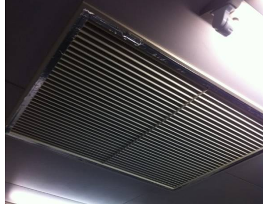
①給気口 天井面に設置 940mm×740mm
