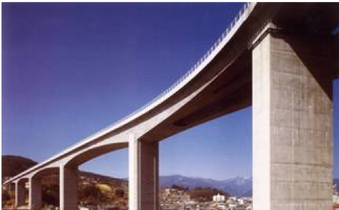
写真 4 長野県 岡谷高架橋
