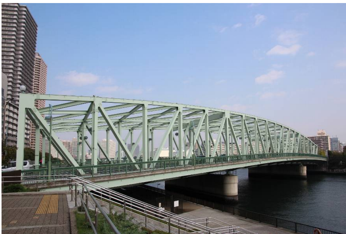
写真2 中央区 相生橋
