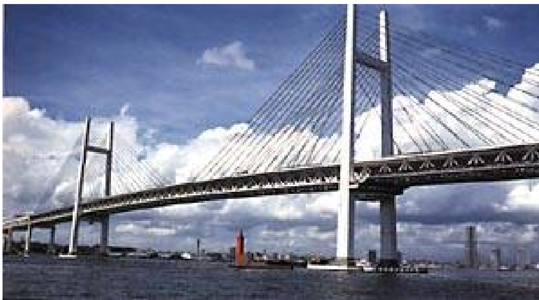
写真5 神奈川県 横浜ベイブリッジ
