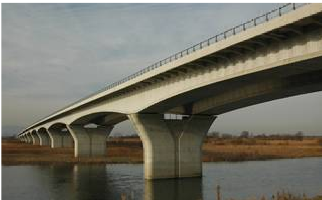
写真1 栃木県 鬼怒川橋
