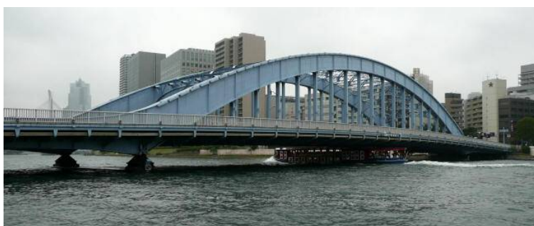
写真 10 中央区 永代橋
