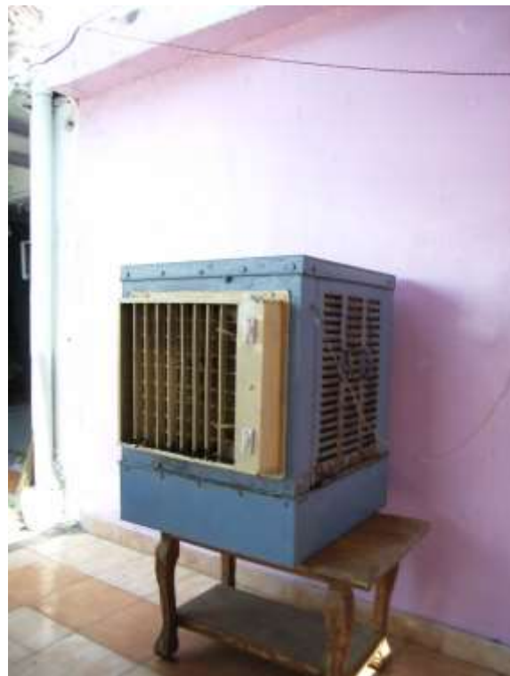
図 16 : インド、アグラ(タージマハル)にある安宿に置かれた「エア・クーラー」の例。 ミストを噴霧するものではない。側面に水を含ませた植物質のフィルターが備わっており、 箱の内部のファンが回るとそのフィルターを通して吸気し、正面から冷気を噴出する。
