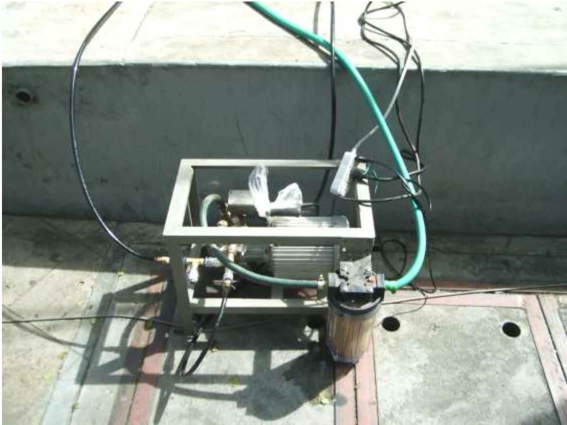
図 5 : 図 2,3,4 のミスト噴霧装置のポンプ部。デンマークの Danfoss 社製。
