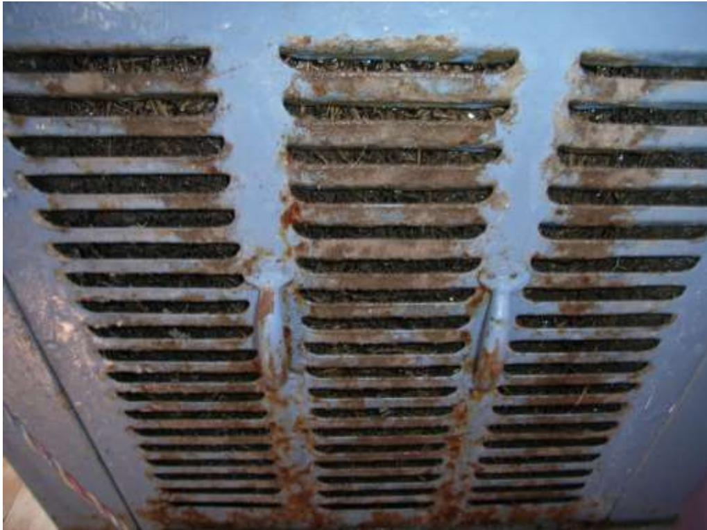
図 17：図 14「エア・クーラー」の植物質のフィルター。ここを通して吸気する。 レジオネラ渦(第 3 章参照)が懸念される。
