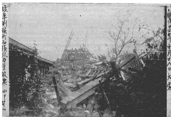
地震直後の岐阜測候所風力台 (出典：1891 年濃尾地震報告書 濃尾地震写真データベース 5) )
