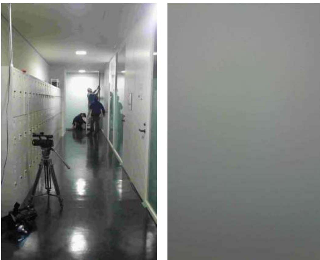
図-55：実験前の様子（右）と煙を発生させた直後の様子（左）
