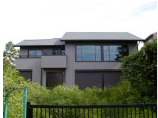
写真-4.1 木造戸建住宅外観
