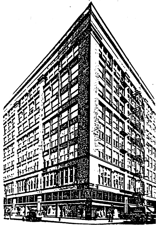
Fig-13: Second Leiter Building (Chicago, 1889-91年) *2
